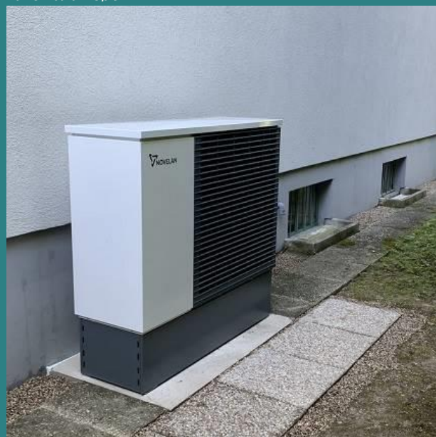
Новата въздушна термopомпа и буферният резервоар малко след монтажа, Източник: инсталаторът
