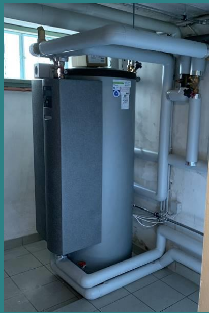
Новата въздушна термopомпа и буферният резервоар малко след монтажа, Източник: инсталаторът
