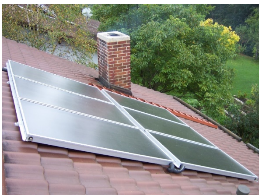
Solarni kolektor toplote instalisan na krovu porodične kuće
