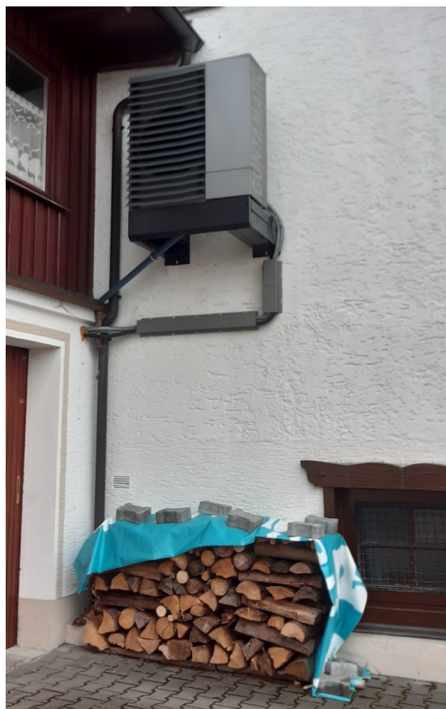
Toplotna pumpa postavljena na zid kuće i priručno skladište ogrijevnog drveta
