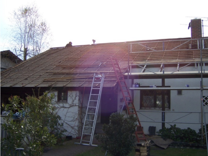
Radovi na sanciji izolacije krova na porodičnoj kući
