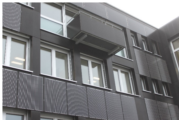
Fotonaponski paneli integrirani u fasadu zgrade
