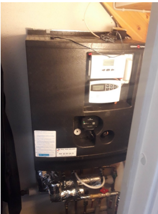
Cijevna instalacija priključka kuće na sistem daljinskog grijanja sa izmjenjivačem toplote
