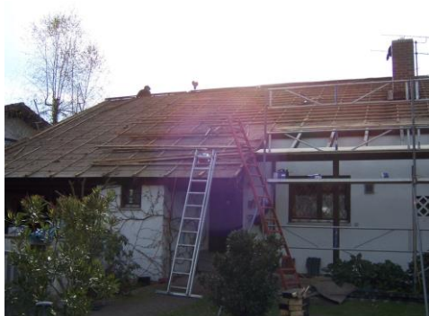
Строителни работи по полагането на изолация на покрива на еднофамилна къща
