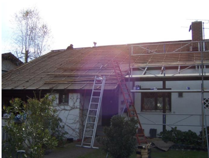
Obras de acondicionamiento para el aislamiento de la cubierta de una vivienda unifamiliar
