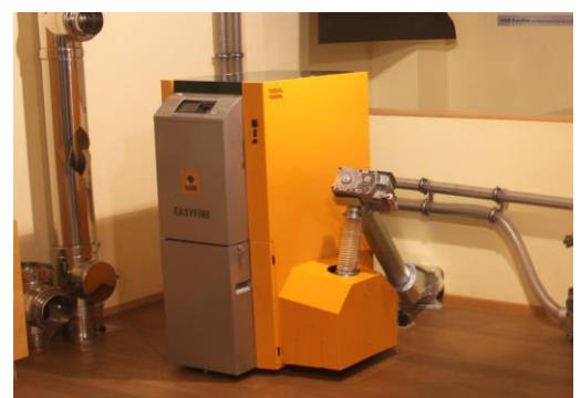
Caldera de pellets de madera para una vivienda unifamiliar
