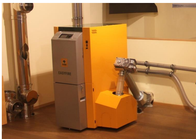
Kotao na pelet u kotlarnici porodične kuće
