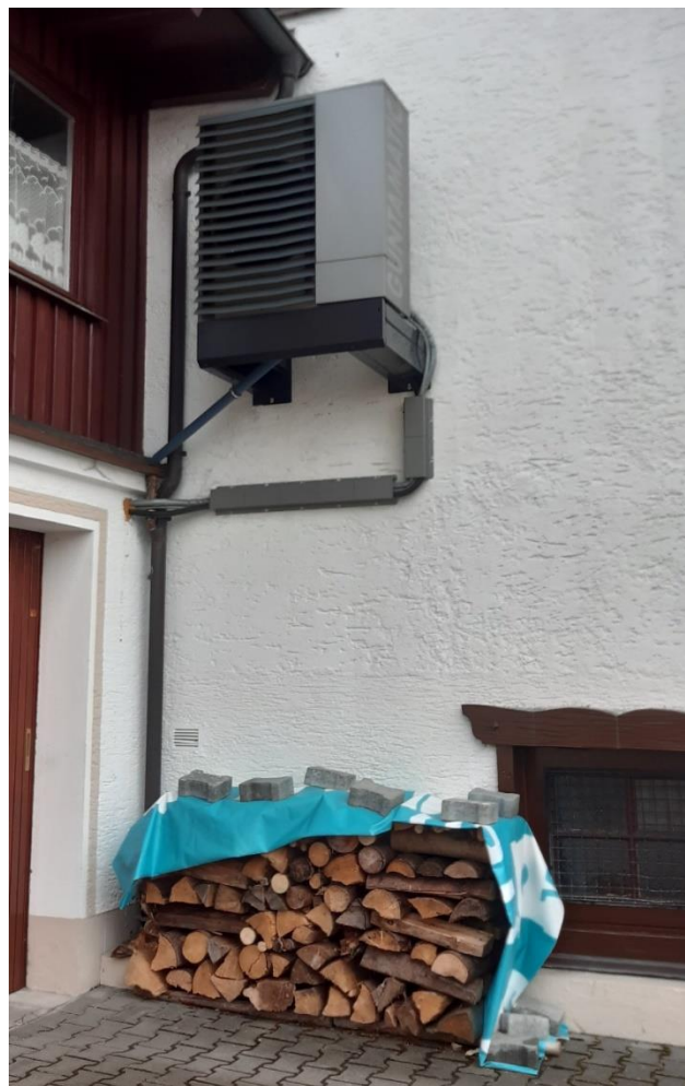
Toplotna pumpa postavljena na zid kuće i priručno skladište ogrevnog drveta
