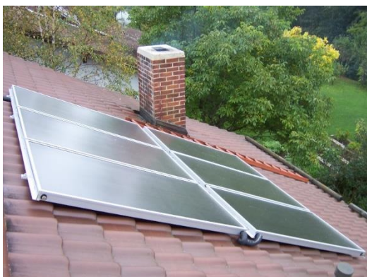
Solarni kolektor za zagrevanje vode instalisan na krovu porodične kuće
