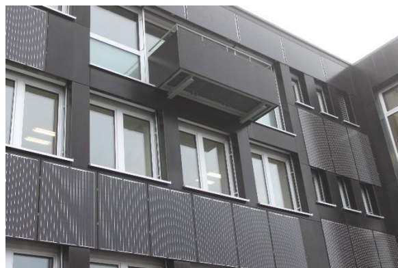
Fotonaponski paneli integrisani u fasadu zgrade
