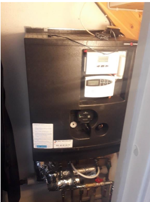
Cevna instalacija priključka kuće na sistem daljinskog grejanja sa izmenjivačem toplote
