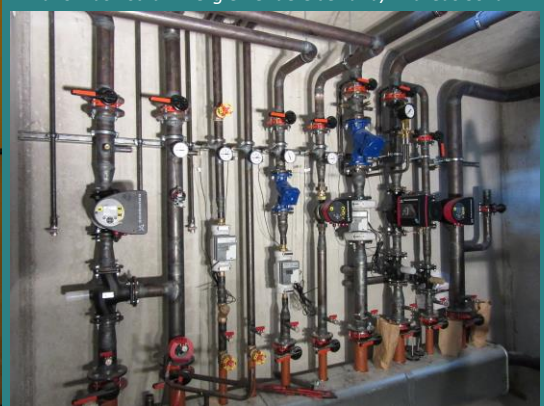
Cijevi za raspodjelu topline Pravo vlasništva: Energiewende Oberland/Andreas Scharli
