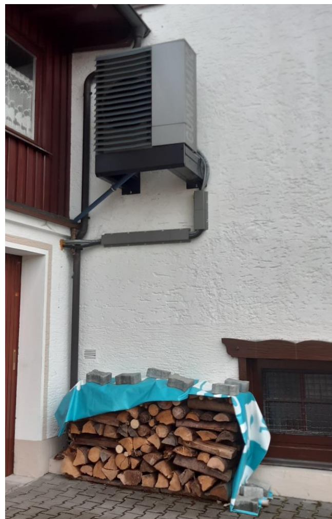
An der Hauswand installierte Wärmepumpe und Lagerung von Scheitholz auf dem Boden
