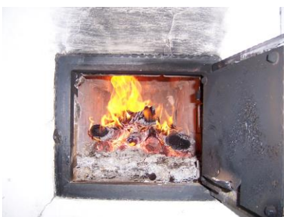
Alter ineffizienter Holzofen
