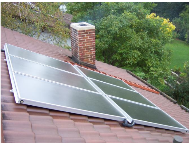
Solarthermie-Kollektoren auf dem Dach eines Einfamilienhauses
