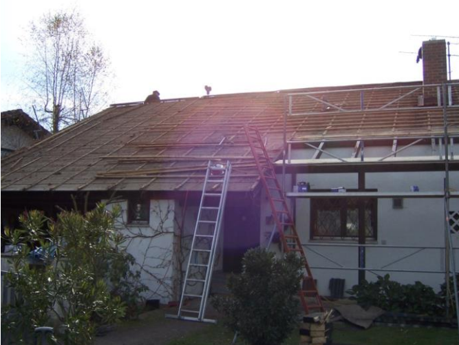
Sanierungsarbeiten zur Dämmung des Daches eines Einfamilienhauses
