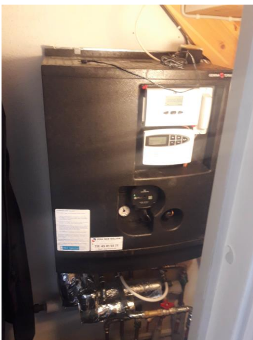
Anschluss eines Gebäudes an ein Fernwärmenetz mit einem Wärmetauscher
