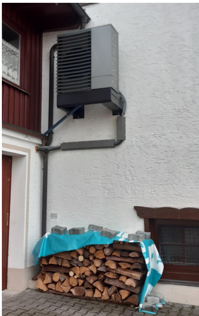
Toplinska pumpa instalirana na zidu kuće uz koje se nalazi i spremište za drva
