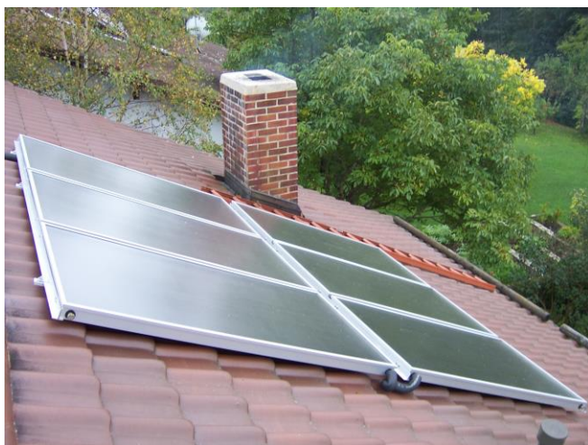
Toplinski solarni kolektori instalirani na krovu obiteljske kuće
