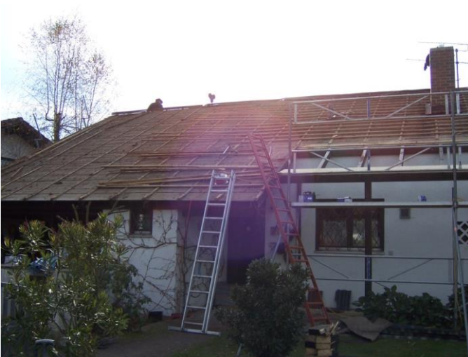
Radovi na sanaciji izolacije krovišta obiteljske kuće
