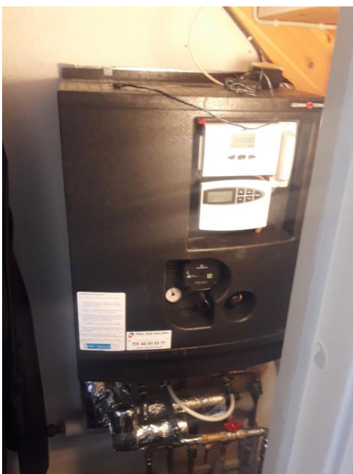
Zgrada povezana na područno grijanje sa izmjenjivačem topline
