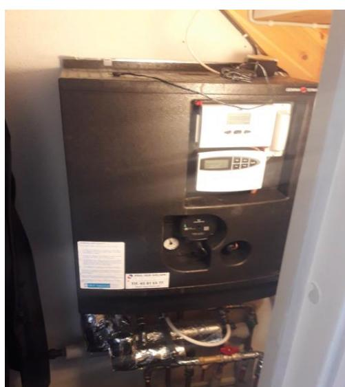
*Поврзување на објектот со централен топлински систем преку топлински изменувач*
