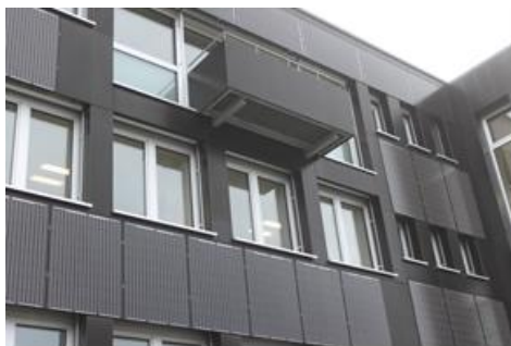
Fotonapetostne plošče, integrirane v fasado stavbe
