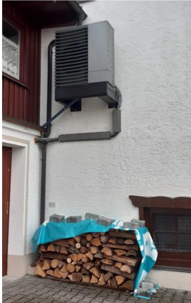
Toplotna črpalka, nameščena na steni hiše in shramba lesa na tleh
