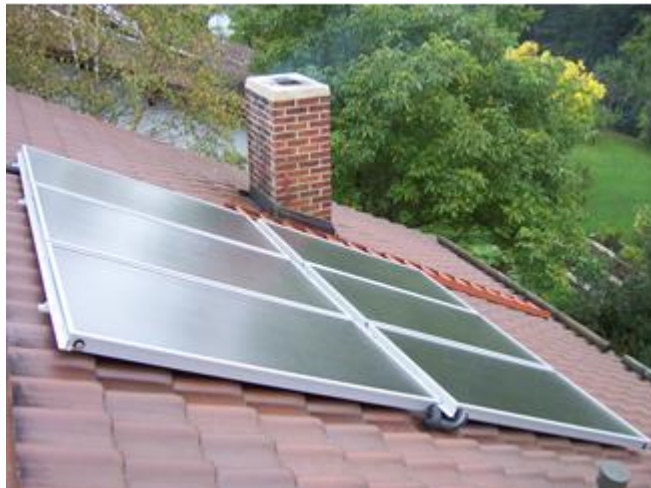
Sončni kolektorji, nameščeni na strehi enodružinske hiše
