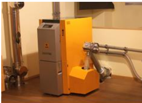
Kotel na lesene pelete za endružinsko hišo
