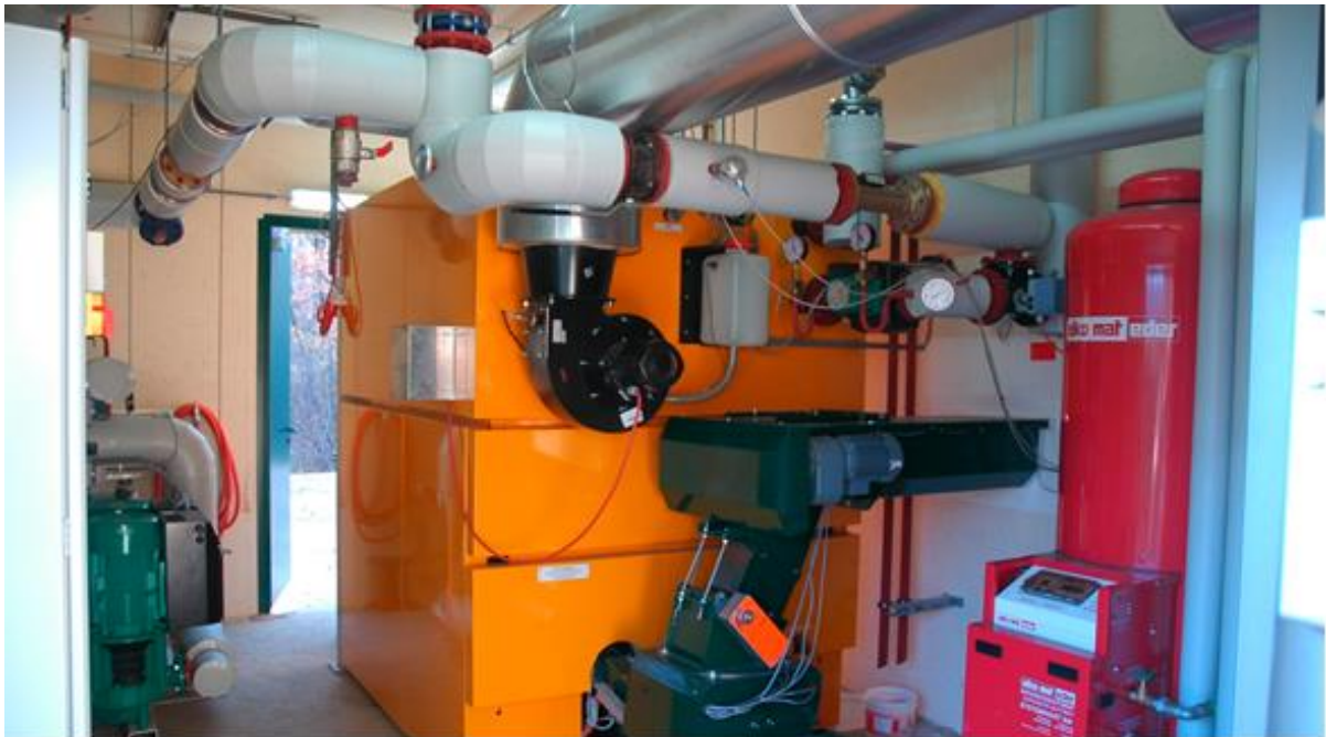
Abbildung 14 Innenraum eines Biomasse-Mikronetz-Heizcontainers
