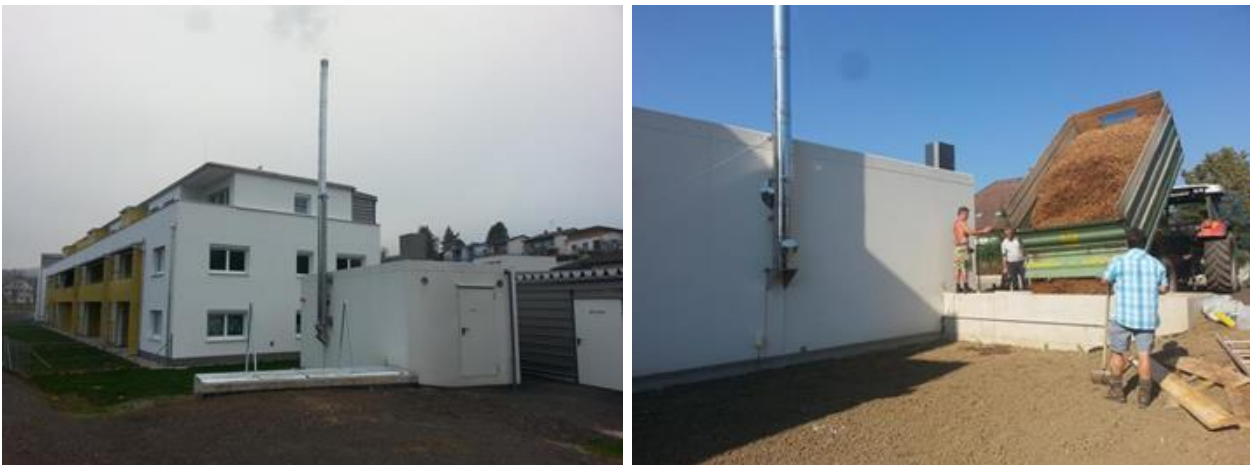
Abbildung 10 Beispiel eines realisierten Biomasse-Mikronetz-Heizcontainers, der Mehrfamilienhäuser beheizt.
