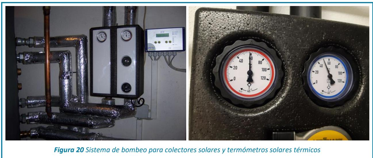
**Figura 20** Sistema de bombeo para colectores solares y termómetros solares térmicos
