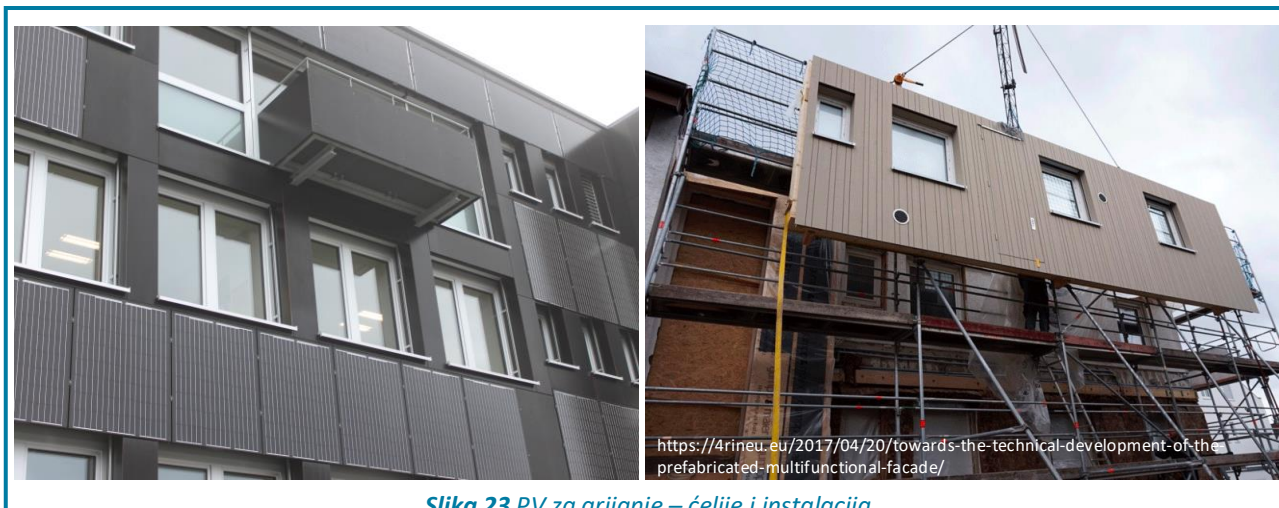
Slika 23 PV za grijanje – ćelije i instalacija
