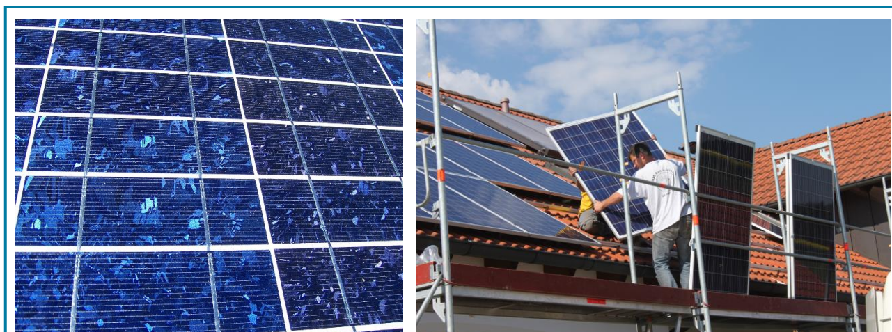
Slika 22 PV za grijanje – ćelije i instalacija
