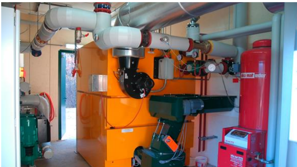
Slika 16 : Unutrašnjost spremnika za grijanje na biomasu u mikromreži
