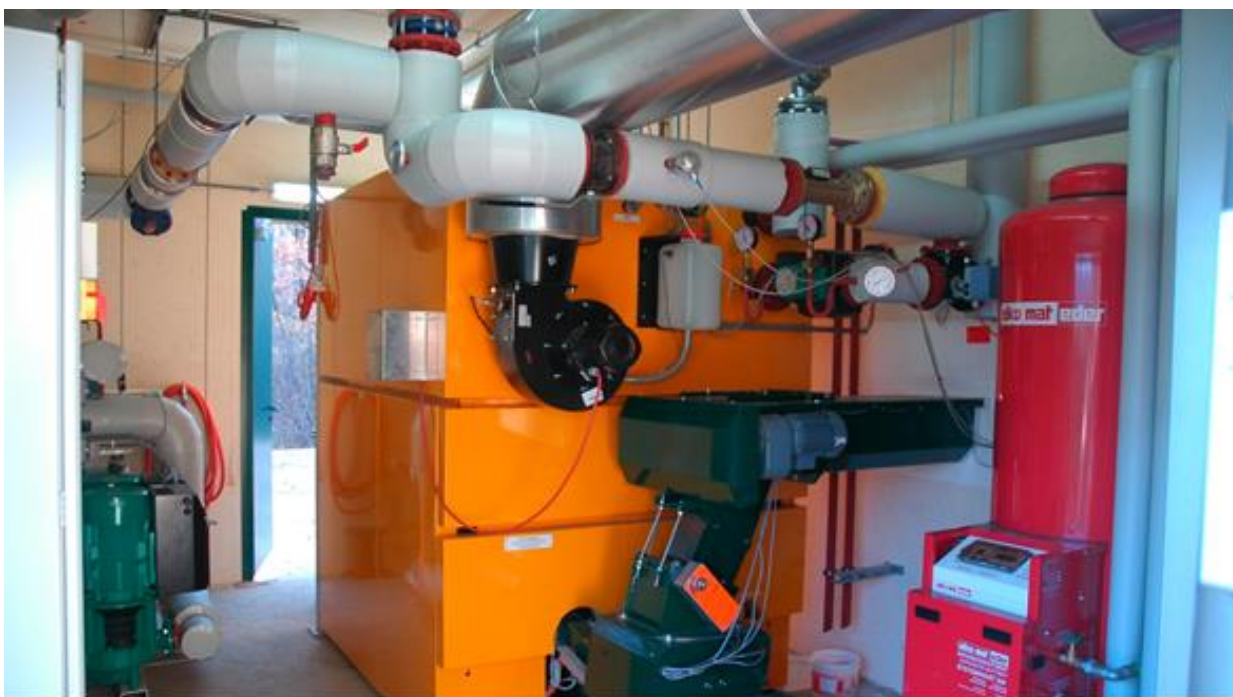
Слика 15 : Внатрешност на постројка на биомаса за греење со микро мрежа
