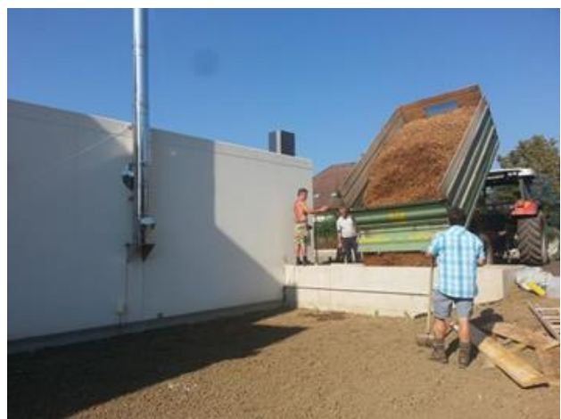
Slika 10 Primer spremnika na biomasu za grejanje, instaliranog na mikro mrežu, grejući blokovi
