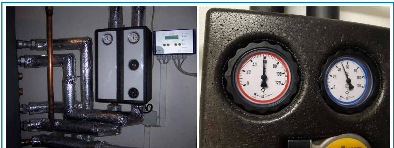
Slika 18 Sistem pumpanja i termometri za solarni kolektor
