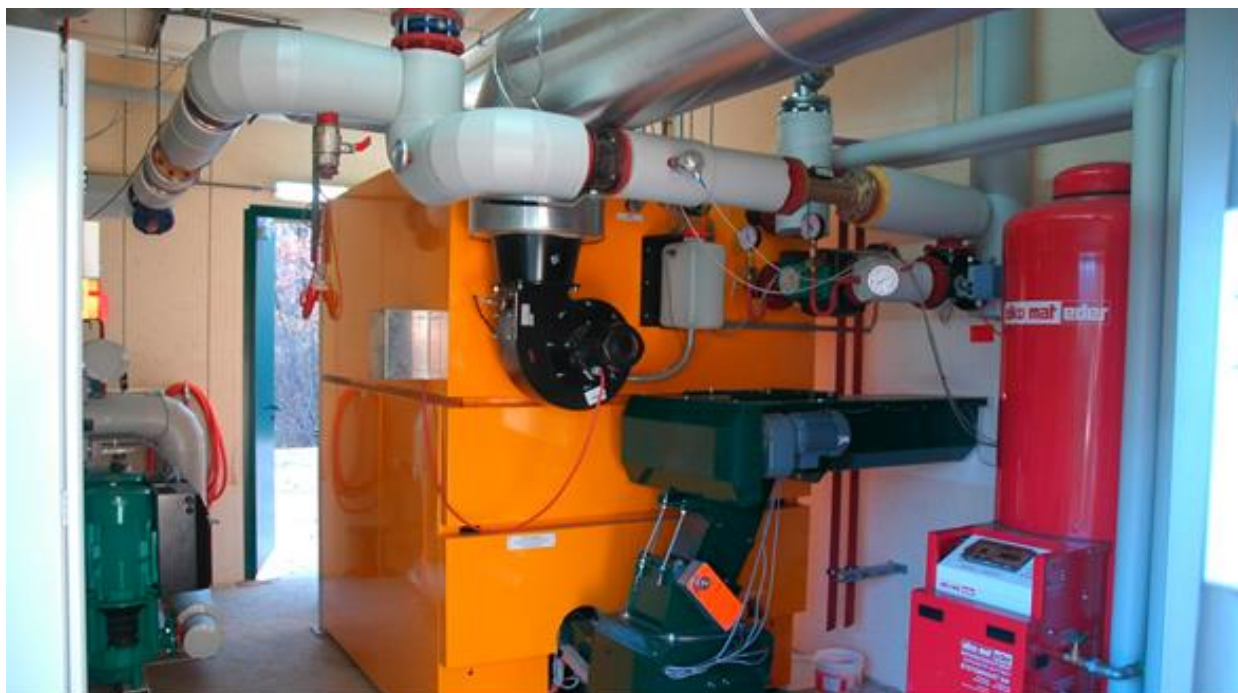
Slika 14 : Unutrašnjost spremnika za grejanje na biomasu
