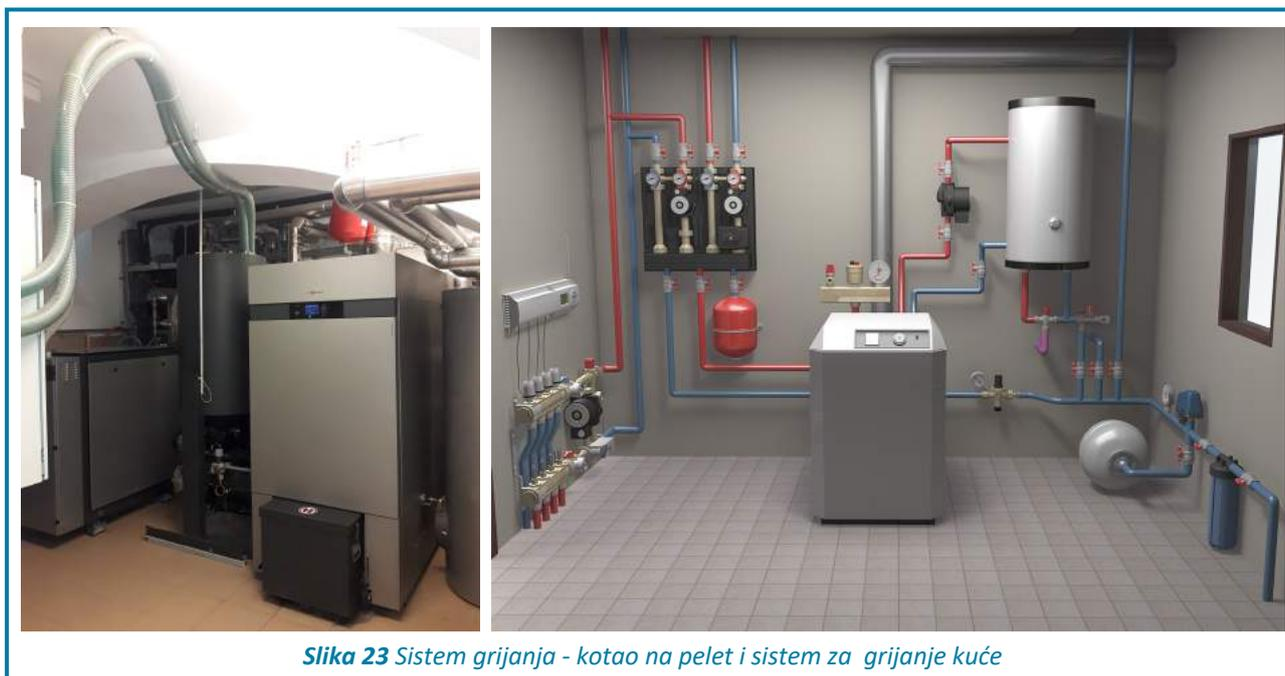
*Slika 23 Sistem grijanja - kotao na pelet i sistem za grijanje kuće*
