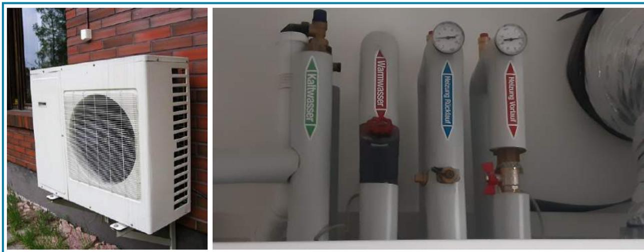
Potrebni ventilski i mjerni priključci moraju se planirati tako da je moguće hidrauličko uravnoteženje sistema. Hidraulično balansiranje mora biti moguće za svaku grupu i prostoriju.
