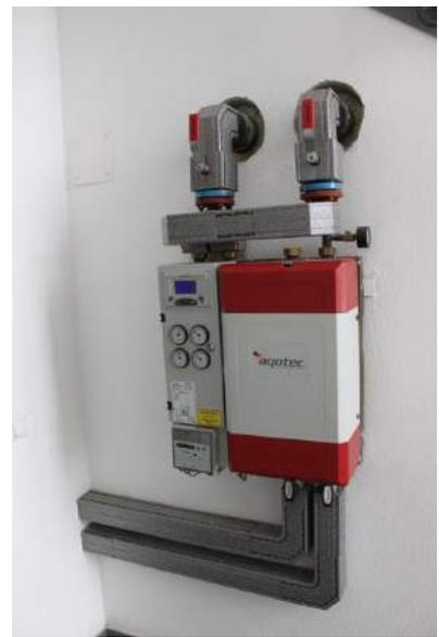
Stanice za prijenos toplote obično se sastoje od izmjenjivača toplote (indirektni sistem), upravljačke jedinice za regulaciju temperature polaza u objekat, ventila i mjerača toplote. Standardno je koristiti motorne ventile uravnotežene sa diferencijalnim pritiskom, kako bi se smanjile fluktuacije i postavila maksimalna brzina protoka kada je ventil potpuno otvoren. Ovim podešavanjem moguće je ograničiti protok (toplotnu snagu) stanice za prenos toplote na ugovoreno zagarantovanu vrijednost.
