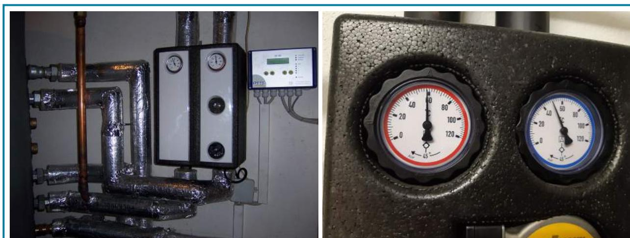
**Slika 18** Sistem pumpanja i termometri za solarni kolektor
