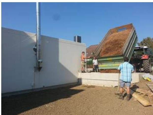
**Slika 10** Primjer spremnika na biomasu za grijanje instaliranog sa mikro mrežom, grijanje stambenih blokova
